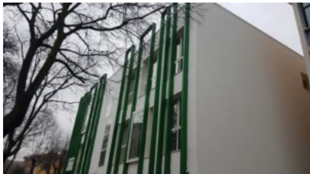
palazzina Bidinelli dell’Istituto tecnico industriale statale “Enrico Fermi” restaurata dopo il terremoto
