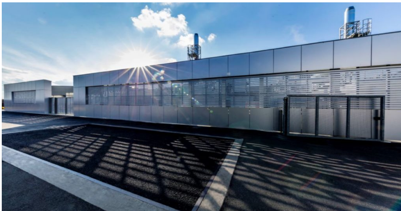
impianto di trigenerazione
